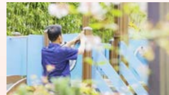
◆ 公用設施的加固維護
